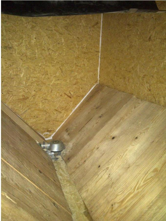
La distance minimale entre les pans inclinés doit être de 35 centimètres. L'inclinaison des pans doit être de 45 degrés minimums. Les parois en contact des pans doivent être siliconées.
