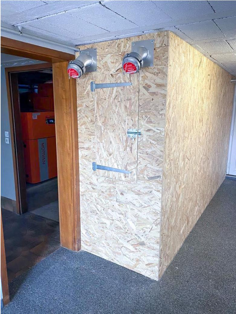
Pour des raisons de sécurité et d'accessibilité, les conduits de remplissage ne doivent pas être installés à une hauteur supérieure à 2 mètres.
