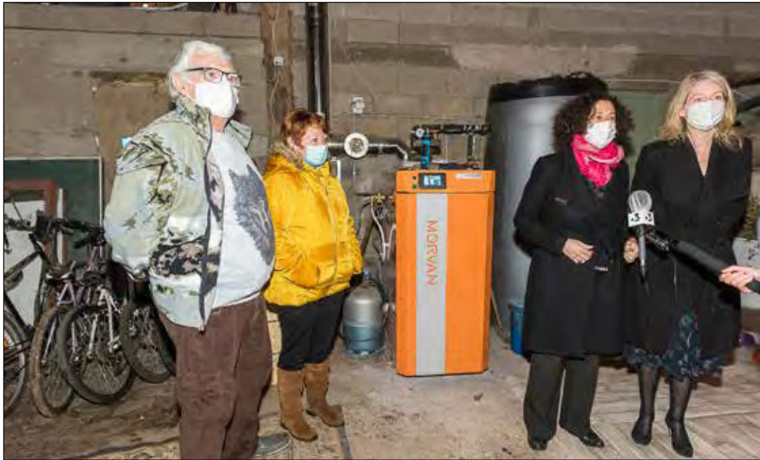
Emmanuelle Wargon et Bérangère Abba (à droite) devant la chaudière de M. et Mme Baudoin.
