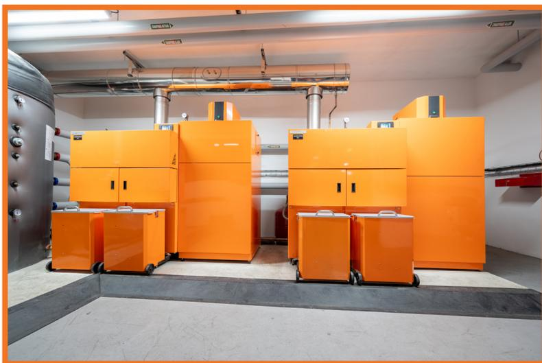
Deux chaudières GM EASY 96 montées en cascade assurent le chauffage central par aérothermes de notre atelier de 2500 m<sup>2</sup> à Torcy en Seine-et-Marne.
